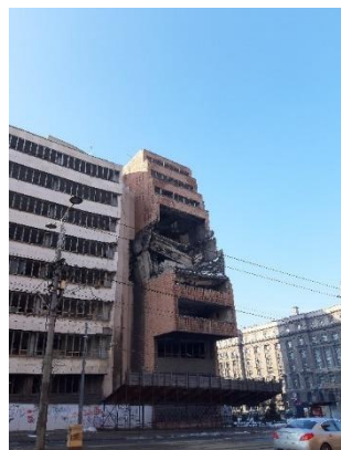
Hrozivý pohled na vybombardovanou budovu ministerstva obrany
